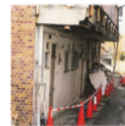
(建物の傷みが著しく外壁の剥落等が生じた事例)
