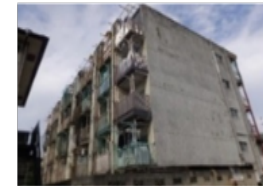
(建物の傷みが著しく外壁の剥落等が生じた事例)
