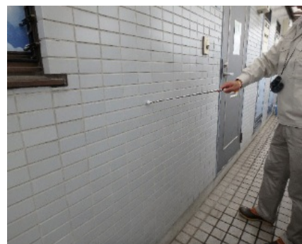
「外部（外壁）」調査の様子
