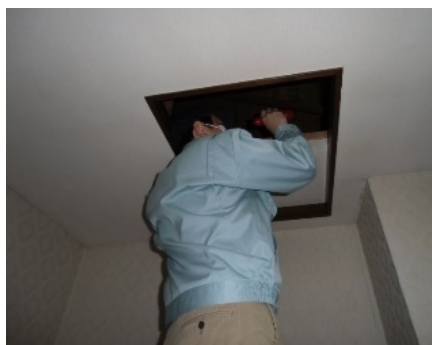
「小屋組・梁」調査の様子
