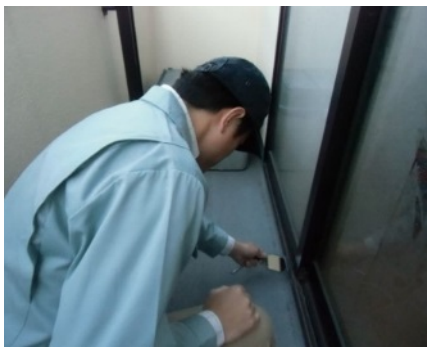
「外部（バルコニー）」調査の様子
