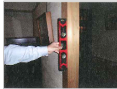
水平器による柱の傾きの計測
